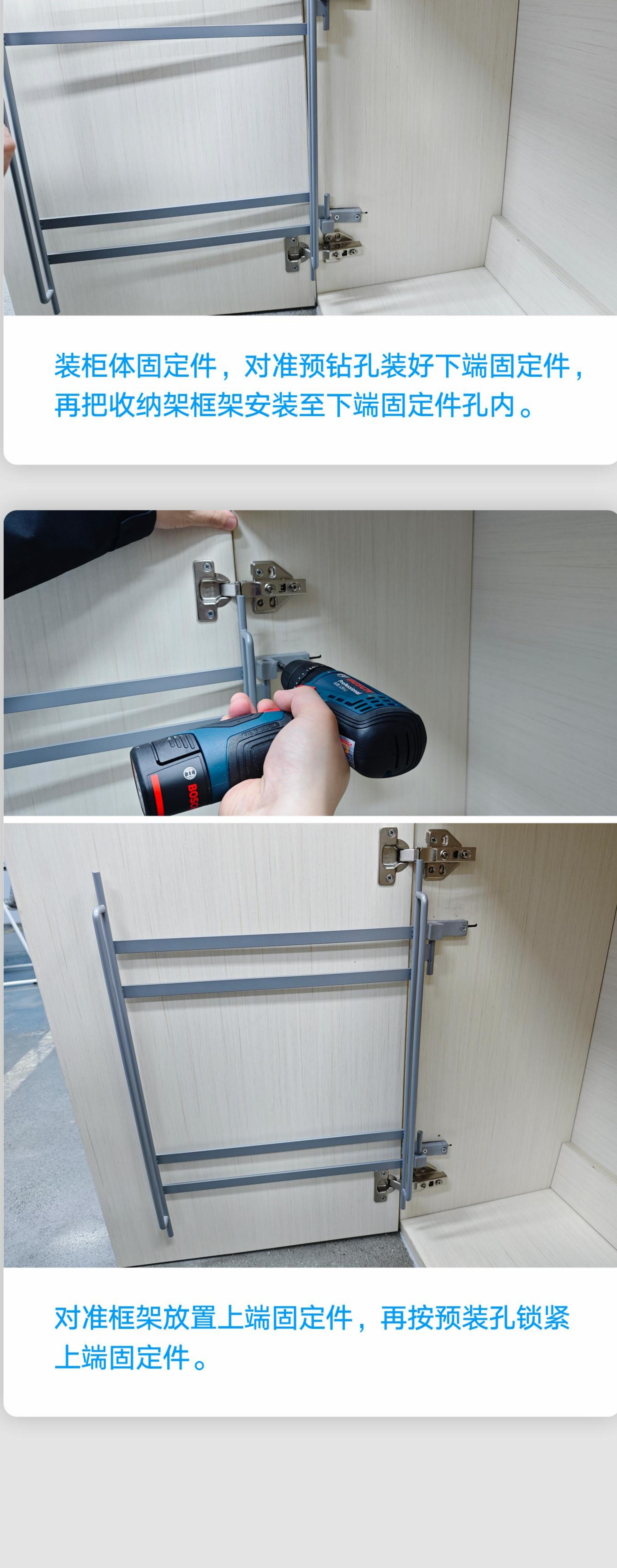
装柜体固定件，对准预钻孔装好下端固定件，再把收纳架框架安装至下端固定件孔内。
