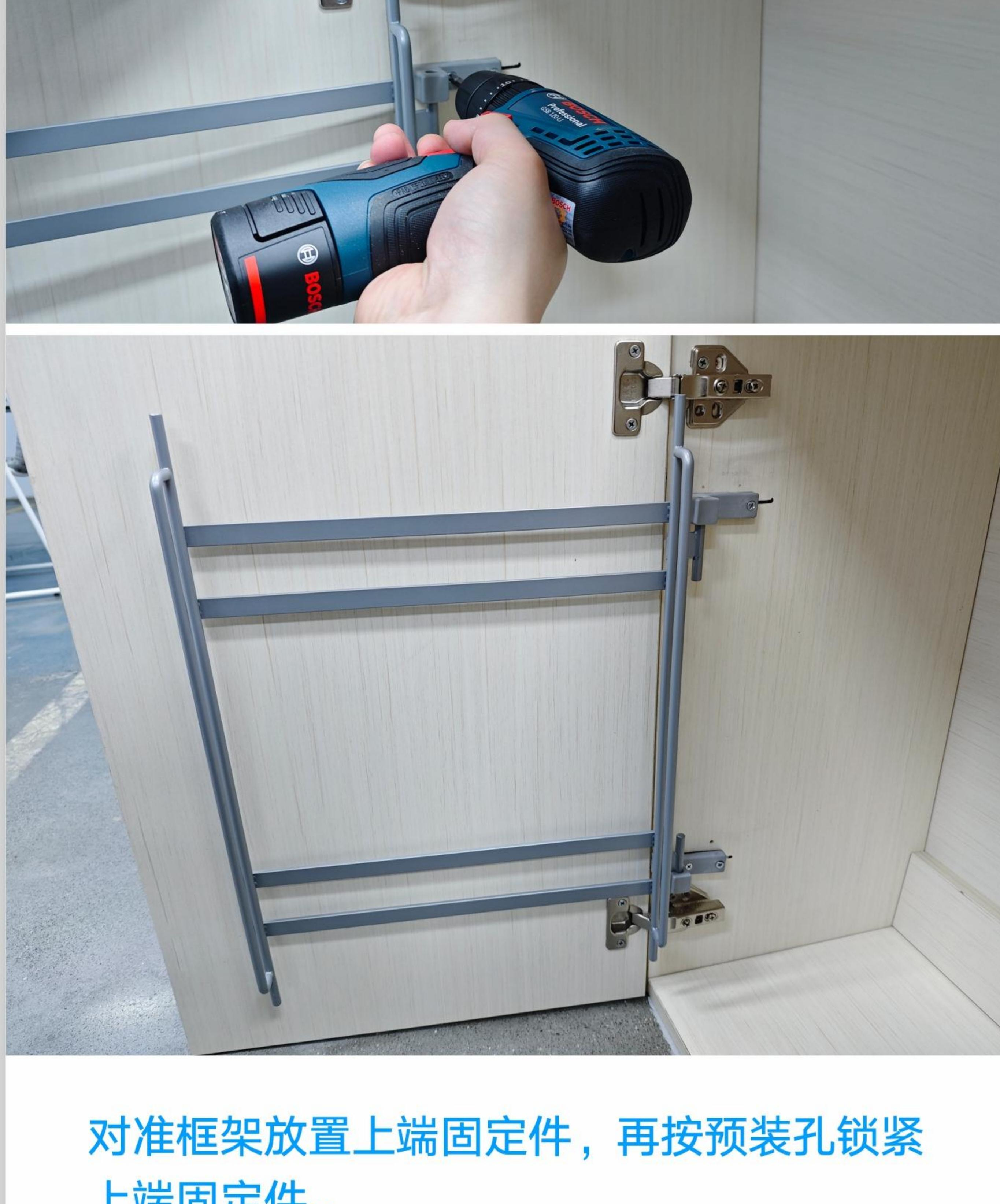
对准框架放置上端固定件，再按预装孔锁紧上端固定件。
