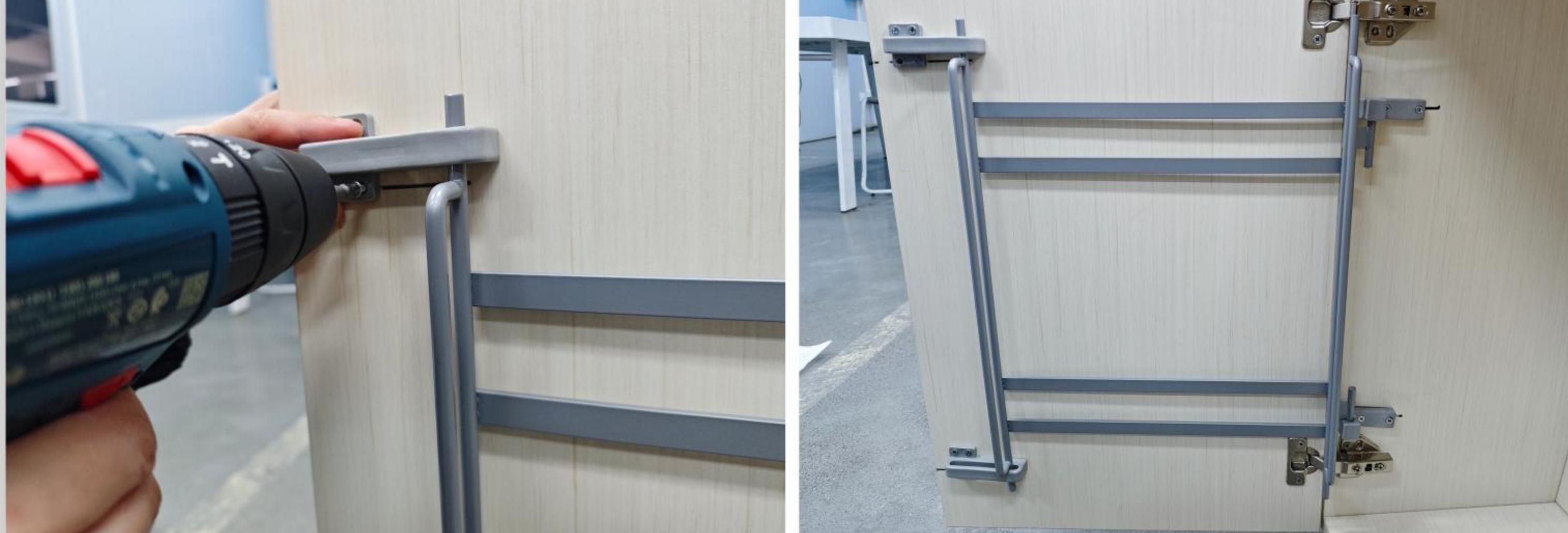
按框架放置上端导向槽支架，然后按基准孔为锁紧上端导向槽支架，柜门安装支架完成。
